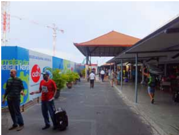
工事中のため、空港内外の至るところに防護壁が。
